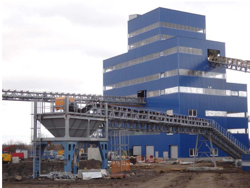
Rys. 5. Zakład przeróbki odpadów węglowych Ostravská těžební a.s. (Pasiowiec 2018)
