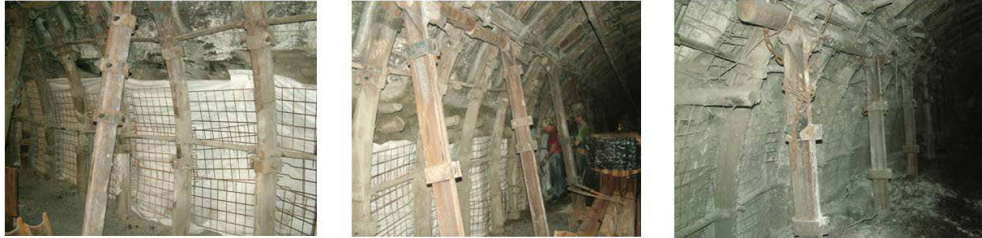
Rys. 8. Widok ociosu chodnika za ścianą po wypełnieniu kasztów i wykonaniu izolacji (fot. A. Ruchel)
