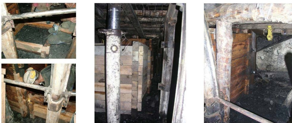
Rys. 7. Widok kasztów budowanych za ścianą (fot. A. Ruchel)
