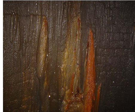
Rys. 20. Widoczne narosty materiału skalnego wyniesionego z za obudowy szybu
