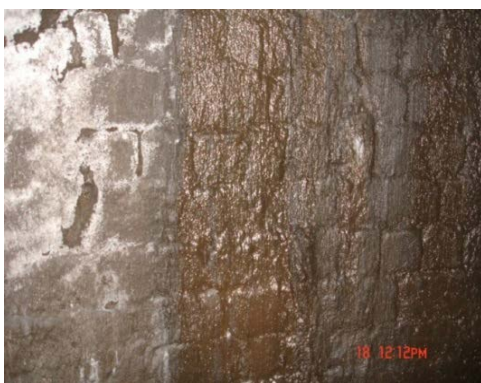
Rys. 13. Zanieczyszczenie obudowy pyłem węglowym Fig. 13. Contamination of support through the coal dust
