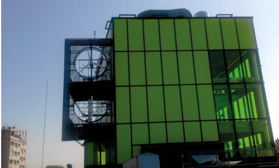
Rys. 1. Konfiguracja turbin przy elewacji budynku Centrum Energetyki (u góry turbina o osi poziomej, na dole turbina o osi pionowej)
