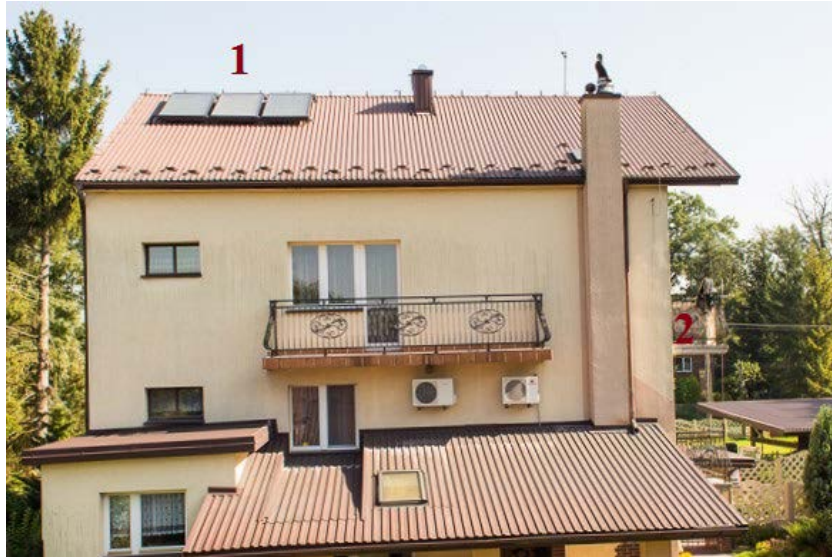
Rys. 1. Budynek z kolektorami słonecznymi (1) i stanowiskiem pomiarowym (2) Źródło: opracowanie własne
