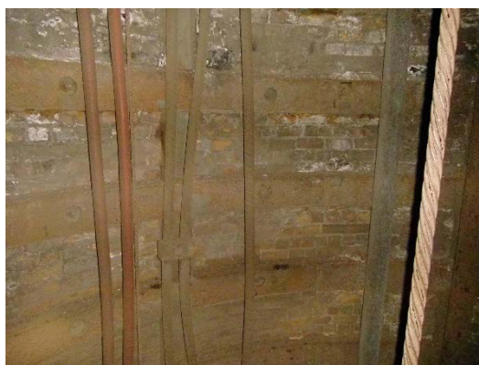
Rys. 1. Aktualny widok pierścieni stalowych w szybie Paweł
