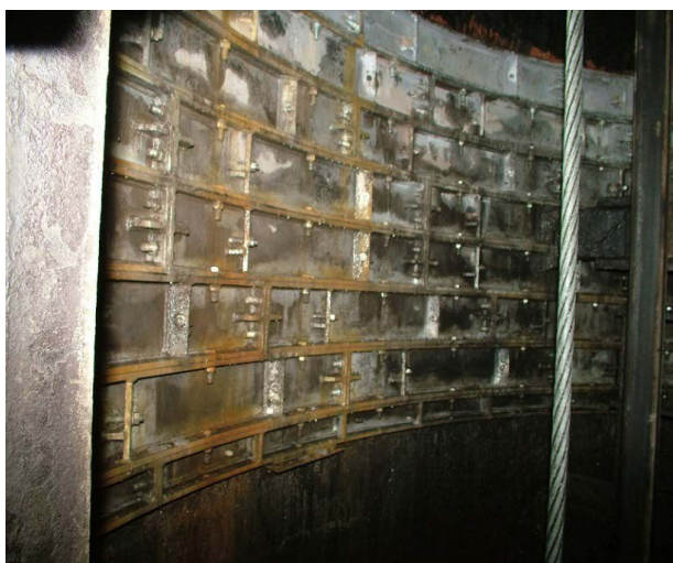
Rys. 8. Widok zabudowanych segmentów stalowych w szybie
