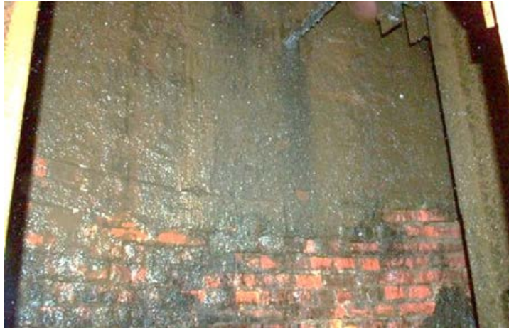
Rys. 3. Zluszczona obudowa szybu wykonana z cegły do głębokości dochodzącej do 20 cm (Bobek i in. 2015)
