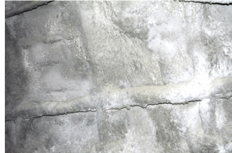
Rys. 19. Wzmocnienie betonem natryskowym z założonymi gnomatami Fig. 19. Reinforcement using shotcrete with profiled meshes
