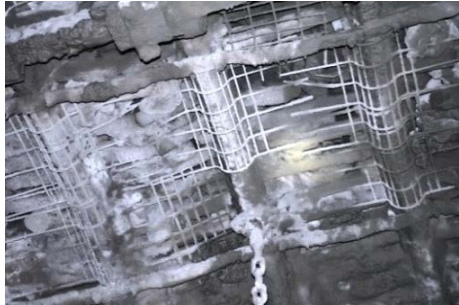
Rys. 18. Nałożone gnomaty na odrzwiia obudowy Fig. 18. Profiled meshes placed on the support sets
