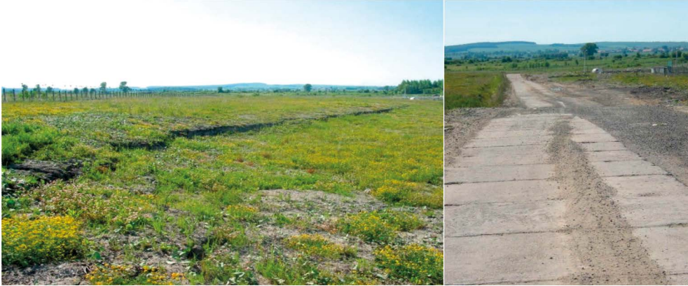
Fot. 2. Widoczne na powierzchni skutki ruchów osuwiskowych w Jaroszwie
