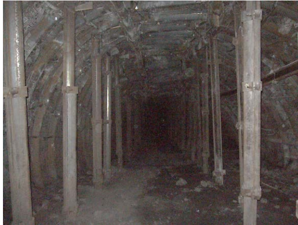
Rys. 6. Widok rozcinki ścianowej w obudowie ŁPKO/V32/10/10 wzmocnionej stojakami stalowymi w rozstawie odrzwi obudowy co 0,75 m w rejonie wpływu krawędzi eksploatacyjnych
