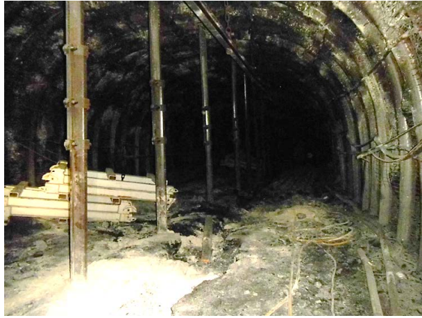
Rys. 16. Widok rozcinki ścianowej 8 w pokładzie 405/3 w obudowie ŁPSPA-V32/4/7,2 × 3,8 w rozstawie odrzwi co 0,75 m wzmocnionej stojakami stalowymi co drugie lub trzecie odrzwia
